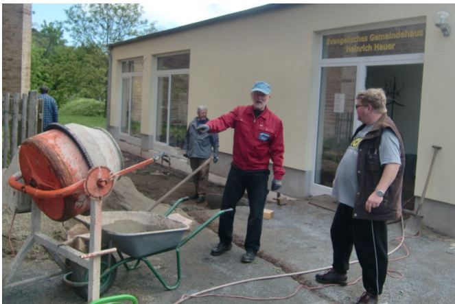
Baueinsatz zur Befestigung der Außenanlage (S. Kiehne)
