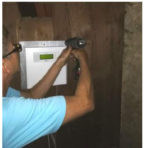
Die Funksteuerung wird eingebaut
